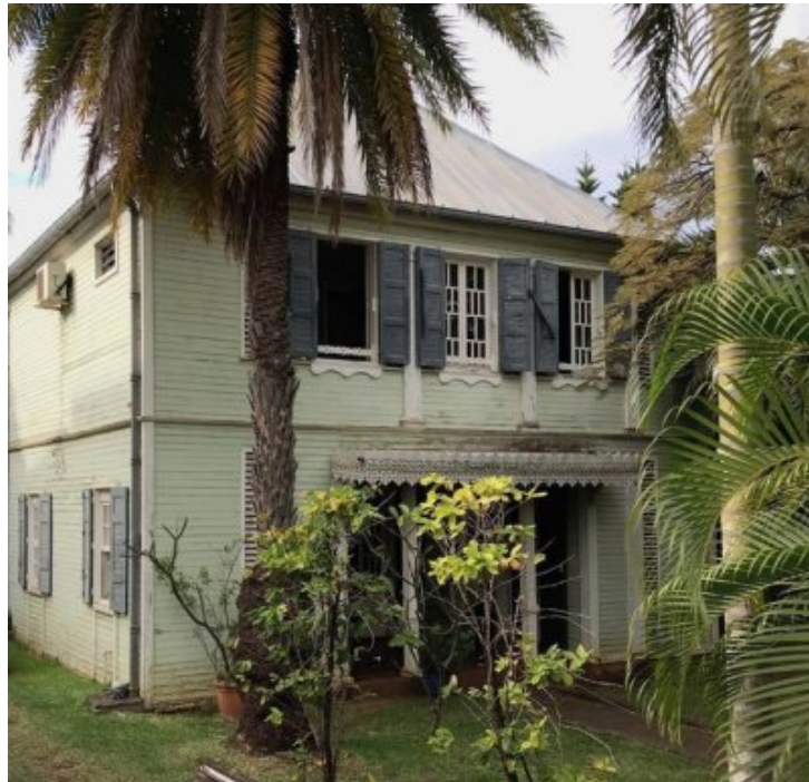
Rue Archambaud, Saint-Pierre. Promise à la destruction. Photo : Bernard Leveueur.
