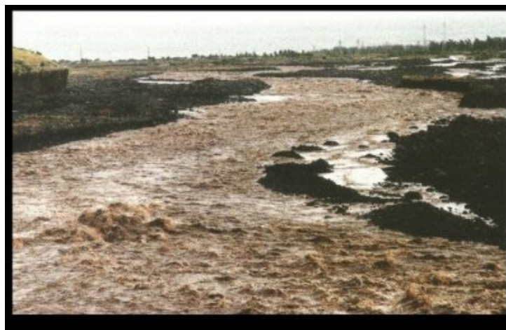
La rivière des Galets en crue, avant l'endiguement.
