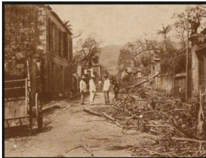
Rue La Bourdonnais, Saint-Denis, après le passage d'un cyclone en 1904 ("Saint-Denis longtemps", Jean-Paul Marodon).
